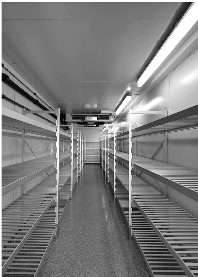
Рисунок 5. Много места для хранения образцов. Температура регулируется потолочным испарителем со встроенным электрообогревателем и холодильным агрегатом с воздушным охлаждением
